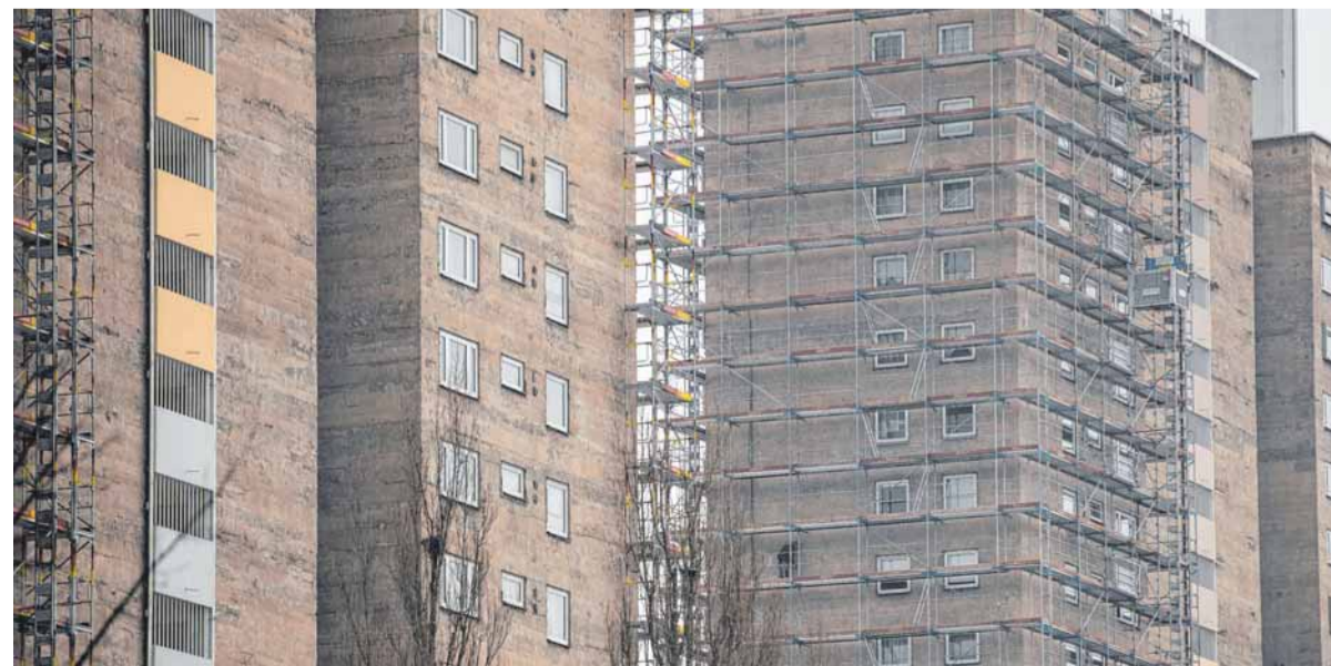
Baugerüste stehen an Hochhäusern im Nürnberger Stadtteil Langwasser, deren Fassaden renoviert werden. Um die Kosten ist Streit entstanden.
